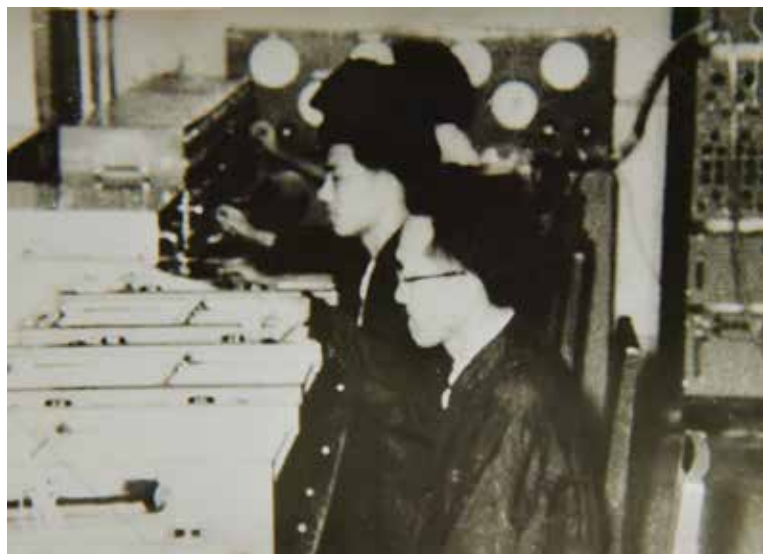
图5 1970年，杨嘉墀在进行返回式卫星姿控系统半物理模拟试验
