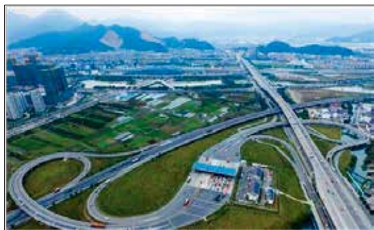
图8 高速公路车口车道变宽 (图片来源于网络)
