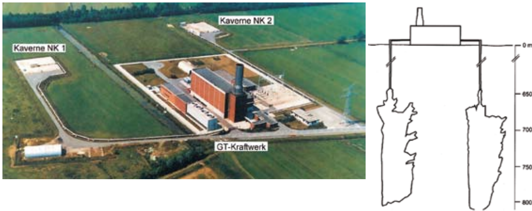
图3 德国Huntorf压缩空气储能电站实景照片（左）及地下盐穴储气库示意图（右）
