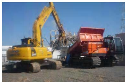
遠隔操作重機によるガレキ撤去作業
